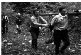
モッコによる運搬状況
