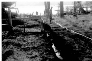
写真1 狐久保遺跡工事立会
