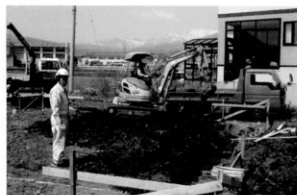
写真19 一里塚遺跡工事立会
