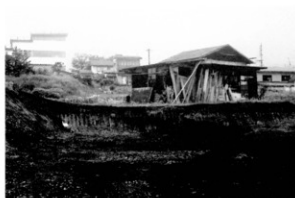
写真20 一里塚遺跡工事立会
