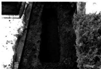
1 トレンチ完掘 (南から)
