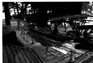
境内掘削工事の様子 (神楽殿前、南東から)
