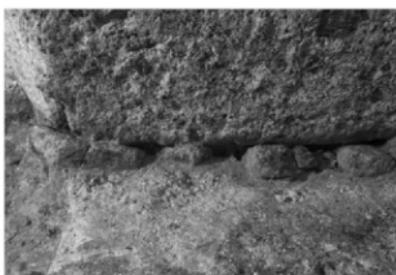
図99 壁石下端に詰められた小石（西壁石2 例面北側）
