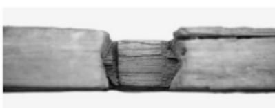
図14 壁板仕口底部に残るノコギリ痕 (南面西壁板2段目)
