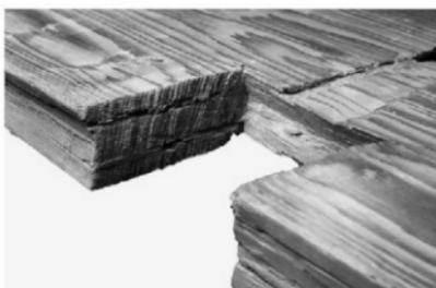
図16 土居との仕口に打ち込まれた割り模 (東面南板壁1段目)
