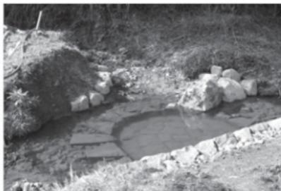
図26 白糸台地における水路合流部の土砂堆積対策
