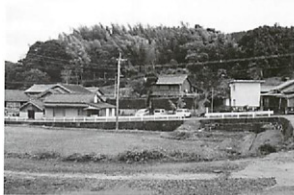
松園屋敷跡 遠景（西から）
