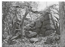
亀岡城跡 大手門石垣(崩落部分)
