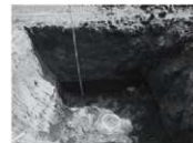
写真40 トレンチ8セクション(N→)
