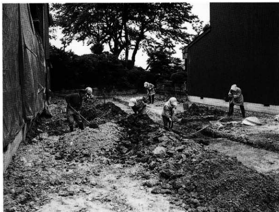
図4 発掘調査状況（北から）
