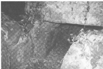
①下峰寺17号墳玄門部 南より
