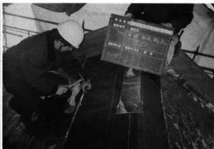
四脚門復元工事（銅板葺き作業状況）
