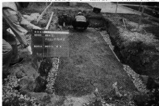
四脚門復元工事（基礎工事の状況）
