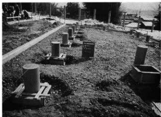
建物表示施設工事（掘立柱設置状況）
