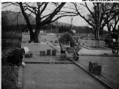
入口広場洗い出しブロック舗装状況
