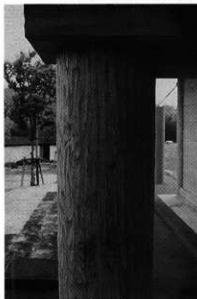
四脚門控柱の加工状況
