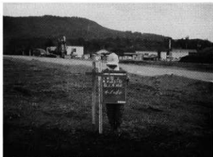
造成工事（盛土厚測定）
