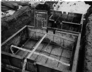
櫛列掘立柱基礎設置状況 (復元可能部分)
