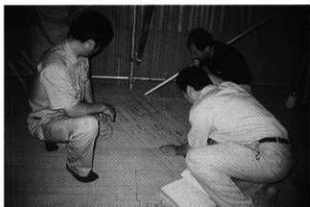
四脚門復元工事（木工事原寸型取り検査状況）
