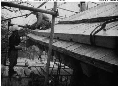
四脚門復元工事（屋根押木取付状況）
