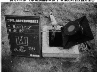
電気設備工事 (欄列ライトアップ施設)
