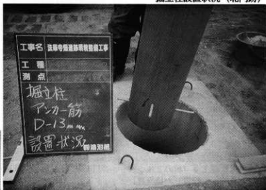
掘立柱設置状況
