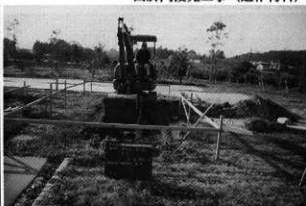
四脚門復元工事（基礎工事の状況）
