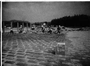
植栽工事（敷芝作業状況）
