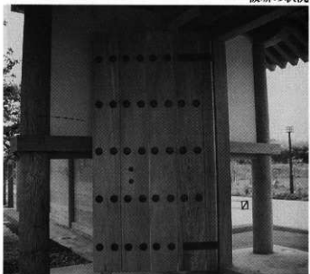
四脚門扉の状況
