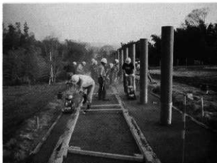
区画溝等舗装工事状況
