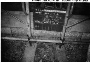
四脚門復元工事（板塀、狭間石設置状況）
