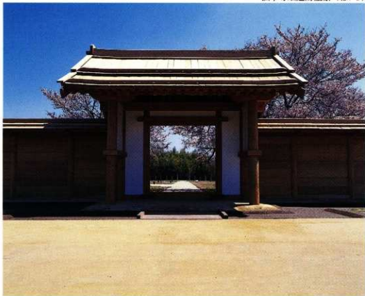
四脚門正面（西から）
