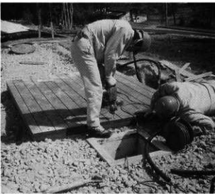
橋の設置工事状況
