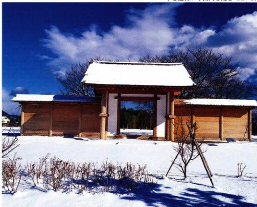
四脚門正面（西から）
