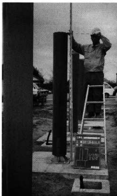
掘立柱設置状況（復元可能部分）
