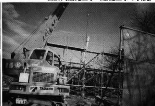
四脚門復元工事（建方着手の状況）
