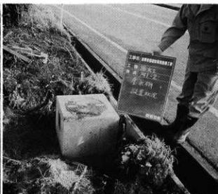
排水工事 (県道側溝に接する集水枠設置状況)
