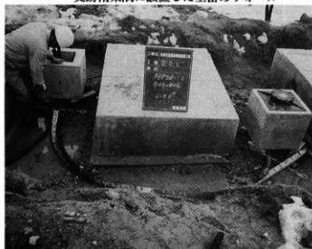
電気設備工事 (欄列ライトアップ施設)
