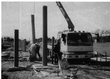
掘立柱設置状況（北門跡）
