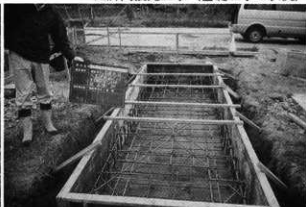
四脚門復元工事（基礎工事の状況）
