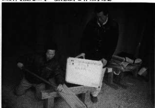
四脚門復元工事（屋根材料加工作業状況）
