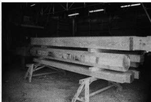
四脚門復元工事（造作材料）
