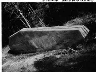
史跡南東隅に設置した土留めウォール
