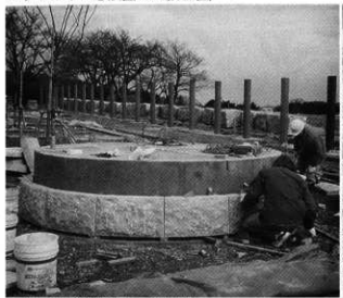
屋外展示模型設置台工事状況
