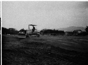
造成工事（盛土敷均状況）
