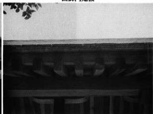
四脚門垂木の状況
