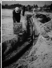
排水工事（透水管布設状況）
