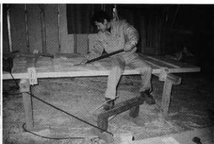
四脚門復元工事（屏加工状況）
