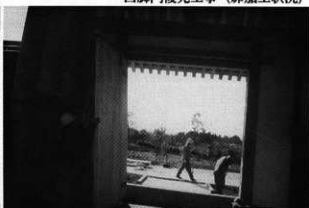
四脚門復元工事（屏取付作業状況）
