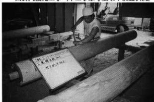
四脚門復元工事（槍鉋仕上げ作業状況）
