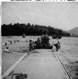
園路工事 (舗装工事状況)
