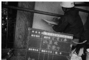
四脚門復元工事（壁、砂漆喰塗り作業状況）
