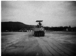
造成工事（盛土転圧状況）
