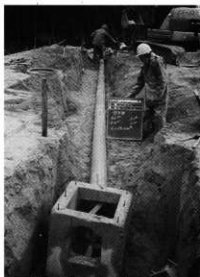
排水工事 (配水管布設状況)
