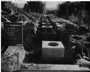
櫛列掘立柱基礎設置状況
