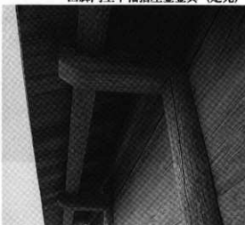
板塼軒裏の状況
