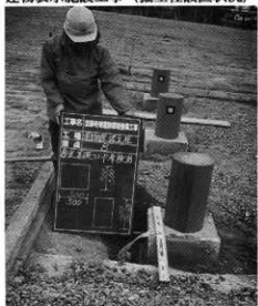
建物表示施設工事（奥の2本、 フットライトを設置した掘立柱）
