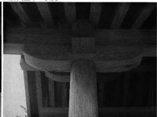
四脚門控柱上部の構造
