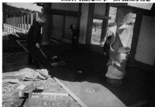
四脚門復元工事（軒内舗装工事状況）
