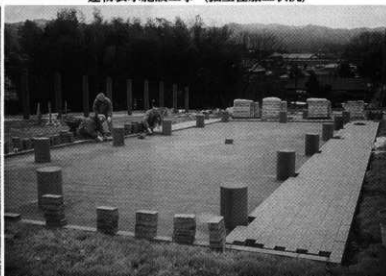
建物表示施設工事（洗い出しブロック舗装の工事状況）
