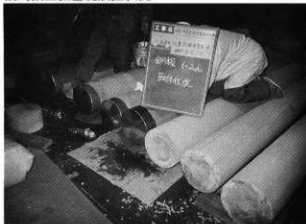
櫛列掘立柱加工状況 (天端銅板取付け状況)
