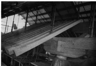
四脚門復元工事（垂木取付状況）
