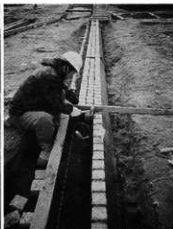
園路工事 (自然石排水溝工事状況)
