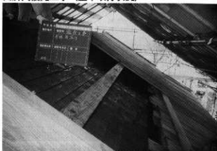
四脚門復元工事（屋根板張り状況）
