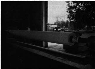
櫛列掘立柱加工状況 (ローリング加工の状況)
