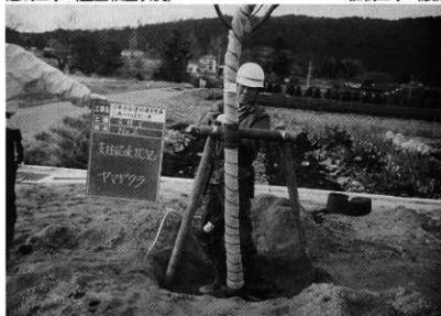
植栽工事（高木植付け作業状況）
