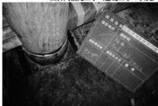
四脚門復元工事（柱足元取付けの状況）
