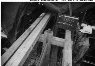
四脚門復元工事（板塀工事状況）
