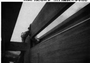
四脚門復元工事（板壁設置状況）
