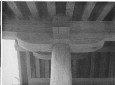
四脚門控柱上部の構造
