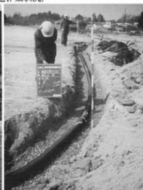
排水工事 (透水管布設状況)
