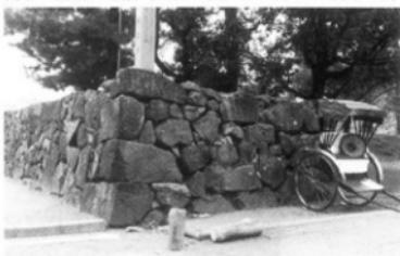
②木戸構門門石垣／現状H=2.1mしかなく史料による石垣高さ1間5尺に根入れを含め約2尺以上積石が消失している
