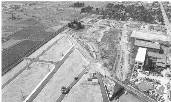
1. 道跡遠景 (東から)
