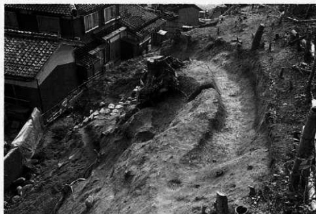
調査後全景 (北東から)
