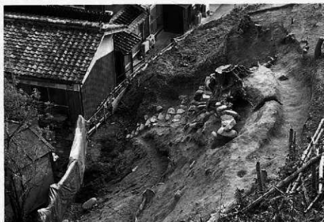
墳丘検出状況 (北東から)
