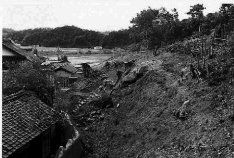
調査前全景 (北東から)
