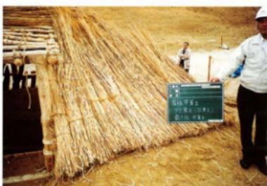
茅葺き（上葺きの最下段は縦方向に本葺き）
