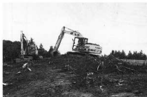
写真① 池ノ谷第2遺跡重機表土制ぎ作業
