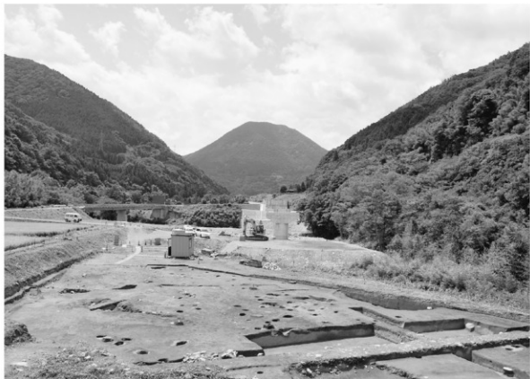
1区南側調査終了状況
