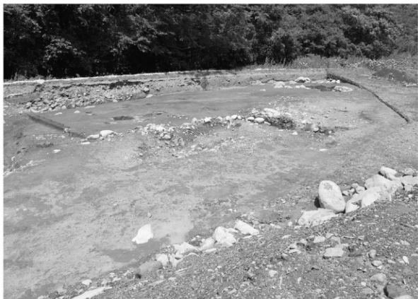
1区北側調査終了状況
