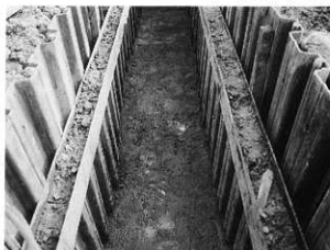
2区完掘 西より
