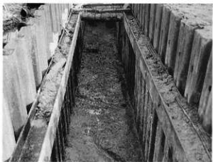
1区完掘 西より
