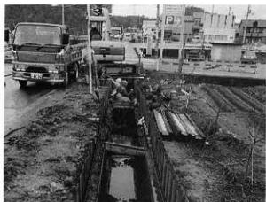
調査風景 東より
