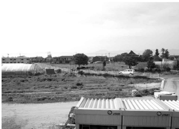
2. 1区-1 調査前(南から)
