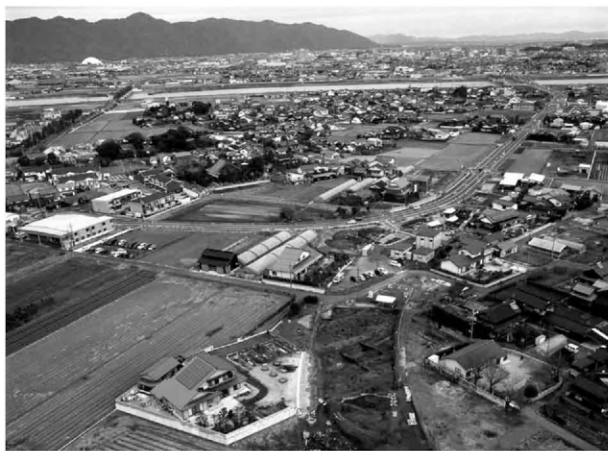
2. 2区空撮 (南から)
