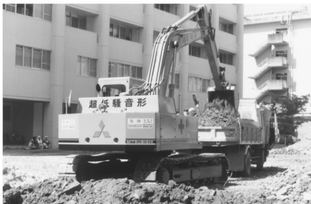
重機掘削風景（北東より）
