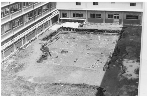
第3遺構面完掘状況（南西より）
