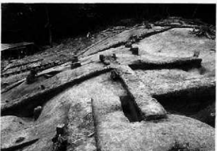
下味野53号墳土層ベルト設定状況(北東から)
