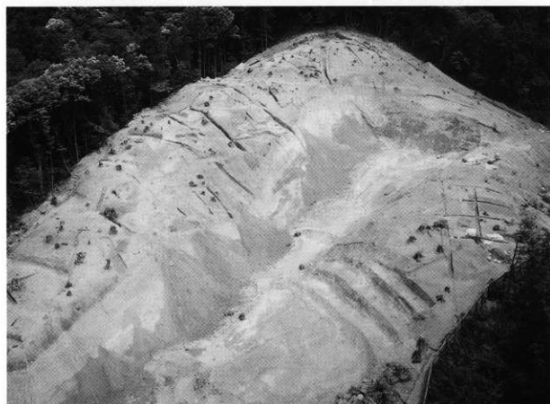
3. 調査地完掘状況(東から)
