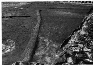
5区 硬化面 (東側から)
