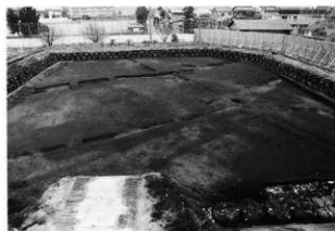
5区 溝全景 (南西から)
