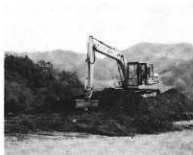
写真1 重機による表土制ぎ
