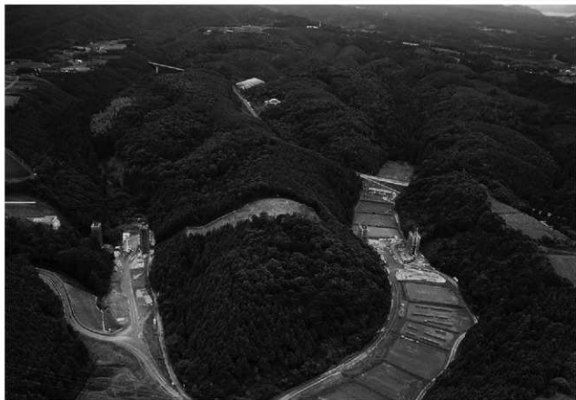
1. 調査後航空写真遠景(北から)
