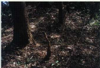
2. 第1地点トレンチ設定状況（北から）
