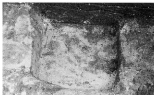
2. SK-2 全景 (南より)
