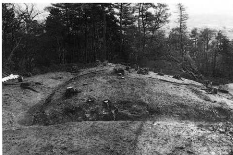
41号墳 墳丘 検出状況 (西から)
