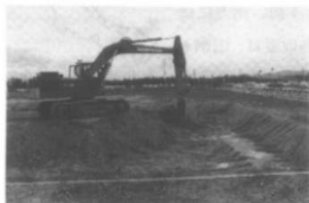
写真2 重機による掘り下げ
