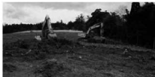
写真1 表土剥ぎ作業風景
