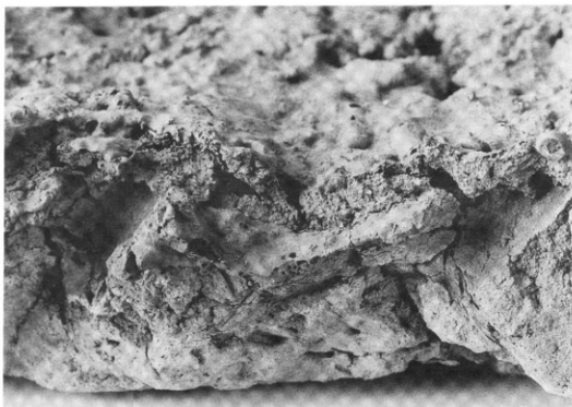
補修痕が観察される炉壁断面の拡大部（PL9の4参照）
