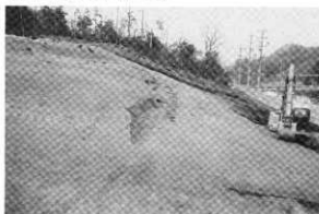
柵列1完掘(南より)
