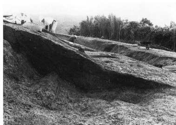
石籠8号墳後円部盛土状況B-B'ベルト北側(東から)
