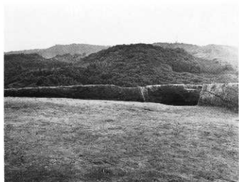
石籠8号墳後円部盛土状況A-A'ベルト東側(北から)
