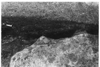
石籠9号墳主体部裏込状況（北東から）
