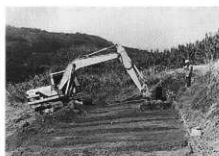
写真① 石鹼第3遺跡森末地区 重機表土制り作業
