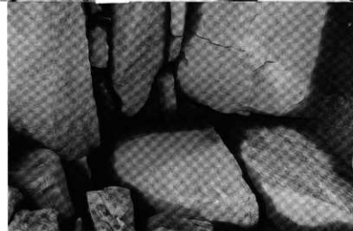
〔3〕 奥壁左側石積状況 (南より)
