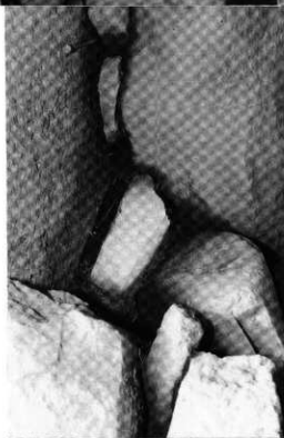
〔2〕 奥壁左側石積状況 (天井石を見上げる)
