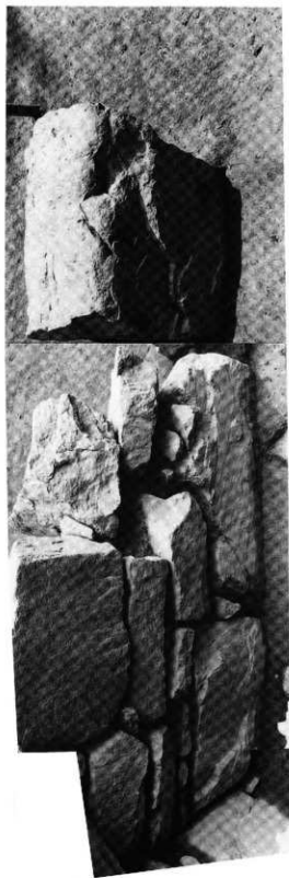
〔1〕右側壁石構状況（西より）
