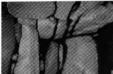
〔4〕 奥壁右側石積状況 (南より)
