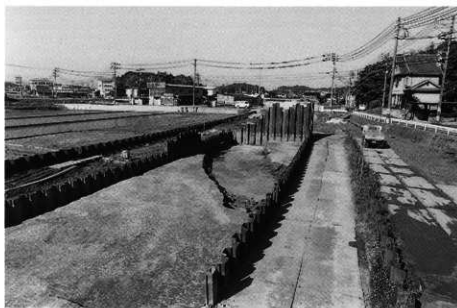
3. 1区水路3 上層完掘(南西より)
