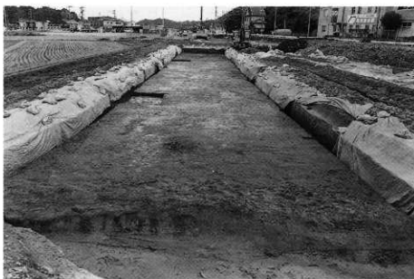
2. 水田面完掘 (西より)
