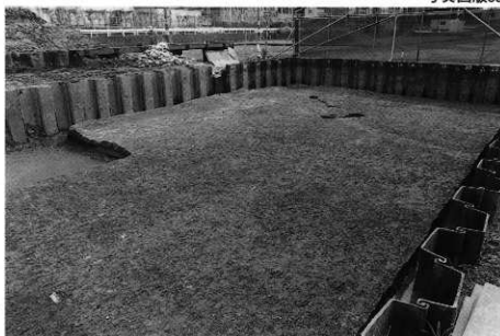
1. 1区水田畦畔 (北東より)
