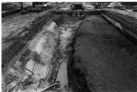
2. 2区水路3 完掘(西より)
