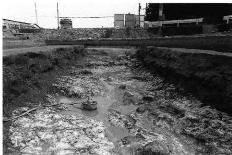
2. 3区水路3 完掘(西より)
