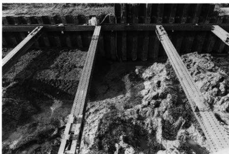
3. 1 区縄紋時代層 完掘(南より)
