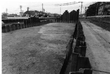
2. 1 区水路3 検出状況(南西より)
