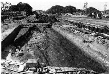
2. 3区弥生時代水田 (東より)
