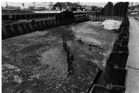
3. 1区護岸遺構 (南西より)
