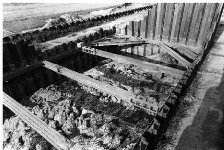
3. 1区縄紋時代層 完掘(南西より)
