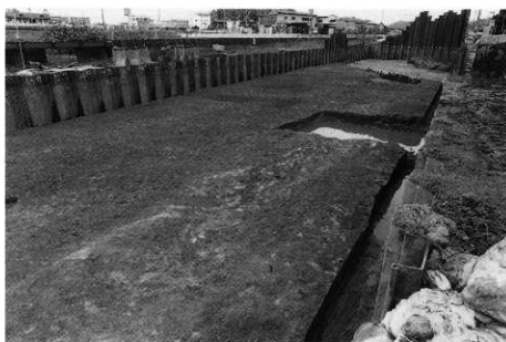
2. 1区水田畦畔 (南西より)
