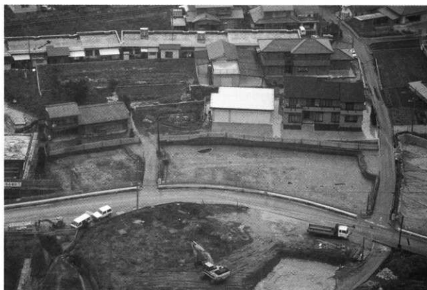
1・2区 完掘状況 (南から)
