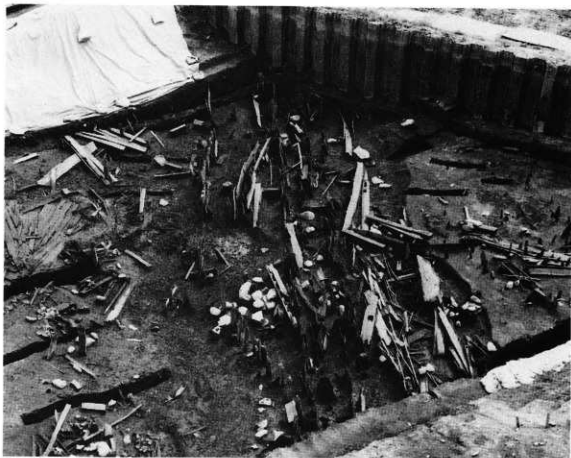
SD38矢板列検出状況 北より
