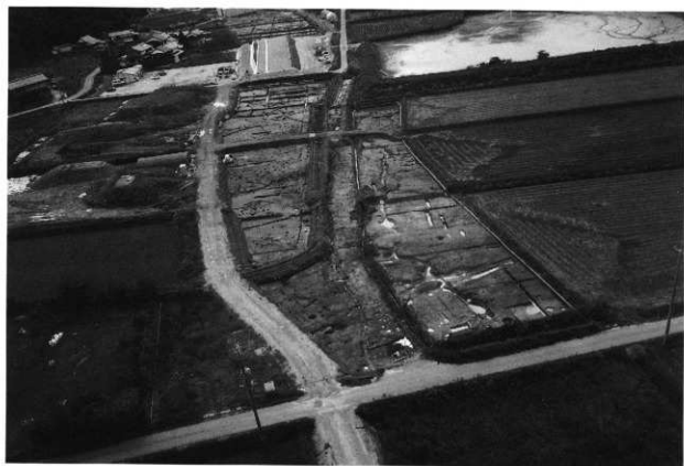
2. 調査区完掘状況（北から）
