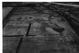
7. 西1区完掘状況 (南から)
