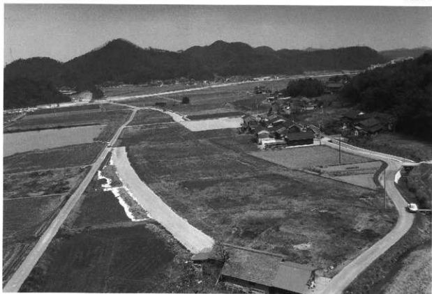
1. 調査前全景 (南西上空から)
