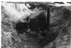
4. S D03杭検出状況 (塚7、北から)
