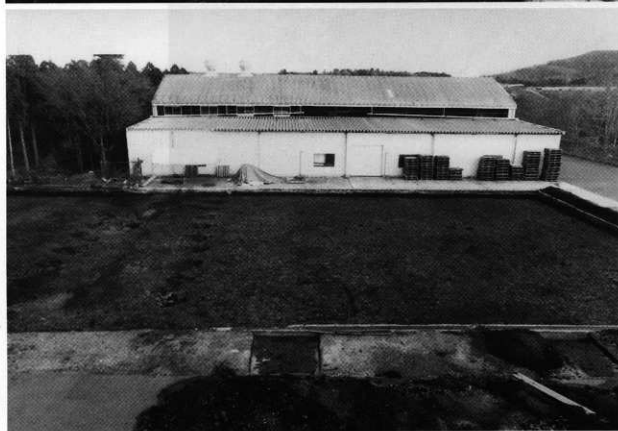
△調査後全景 (北東から)
