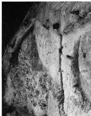
S 110完壁状況 (北より)
