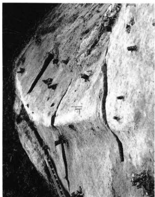
土層状態押出し状況 (北より)
