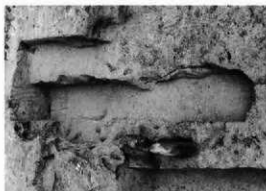
同 掘り上がり
