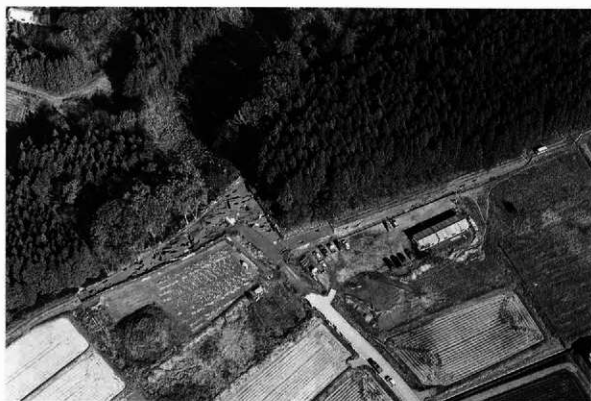
調査区全景（次年度）（南側上空から）
