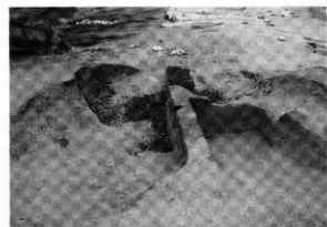
岩手沿岸北部地震による崩落状況
