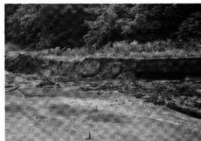
岩手沿岸北部地震による壁面崩落状況
