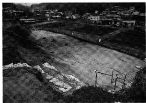
ⅢD区終了全景（南東から）
