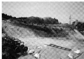
沢跡B検出 (北東から)
