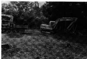
C 南側調査区表土除去状況
