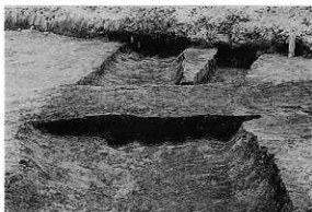
RG319・323溝跡断面 (南西から)
