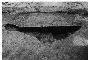
同左断面（北から）
