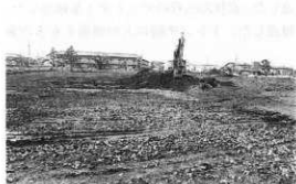
重機による表土掘削
