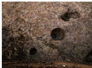
第2調査区噴砂（南より）
