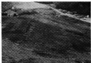
北谷部現況 (南から)
