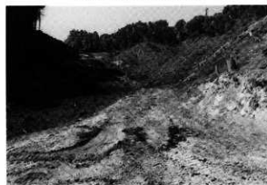
南谷部現況 (北東から)
