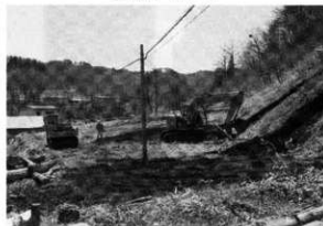
重機による表土掘削状況（北から）
