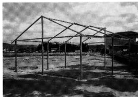
復元した竪立柱建物
